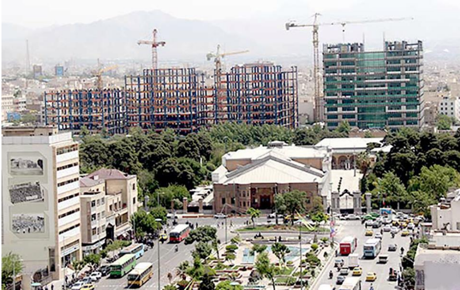
نمایی از اسکلت‌های ساختمان‌های در حال ساخت در محوطه‌ی مجلس
